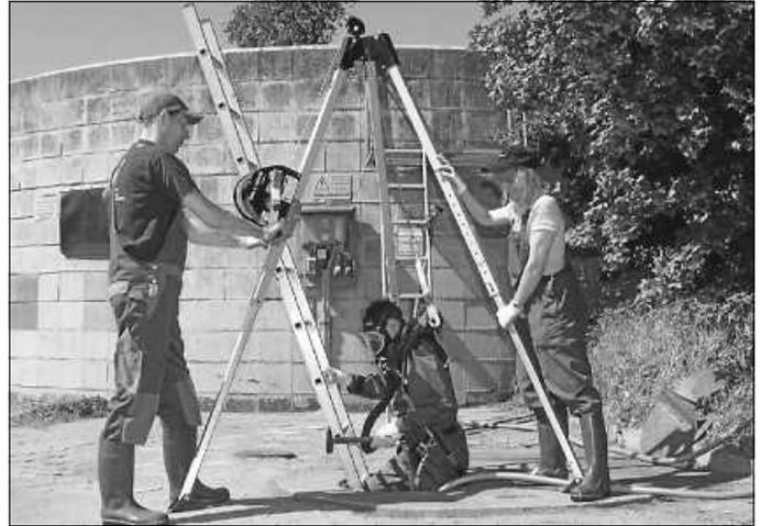
*Einstieg ins Güllelager am Rettungsgurt mit einem umluftunabhängigen Frischluftgerät – gesichert durch zwei Personen. Foto: SVLFG*
